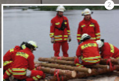
Hauptauftrag in der Übung: eine Wasserleitung durch die Havel legen, um vom Hochwasser eingeschlossene Bewohner mit Frischwasser zu versorgen. Dafür war wegen der großen Distanz auf halber Strecke eine Pumpstation notwendig, die auf einem Floß (Foto 1 bis 4) installiert wurde.
