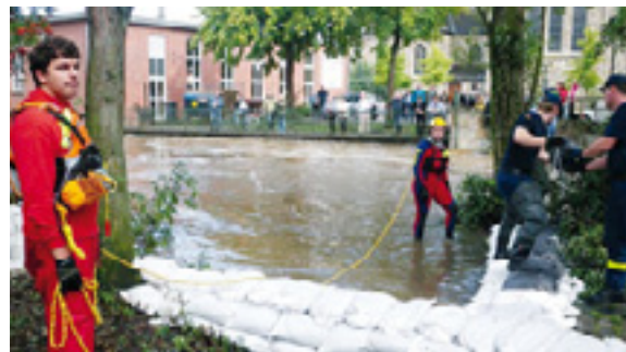
... folgte das Befüllen und Verbauen von Sandsäcken
