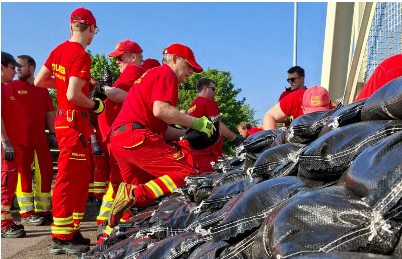
Hochwasserschutzwand mit Hilfe von Europaletten und Sandsäcken.
