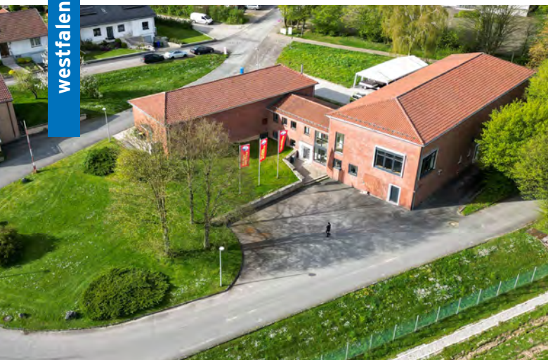
Das 1.000 m 2 große Gebäude der DLRG Büren wurde vor 70 Jahren als Umspannwerk gebaut und ist heute als Vereinsheim der DLRG ein Leuchtturmprojekt. © DLRG Büren (5)
