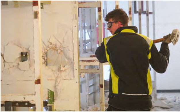
Für die Entkernung des Gebäudes leisteten die Bürener Retter einen wahren Kraftakt - nahezu alles von Hand und in Eigenleistung.
