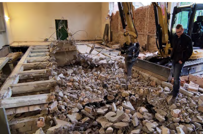
Einst waren hier große elektrische Anlagen untergebracht. Diese mussten per Handarbeit Stück für Stück demontiert werden. 30 Tonnen Gips und zehn Tonnen Stahl kamen so zusammen.
