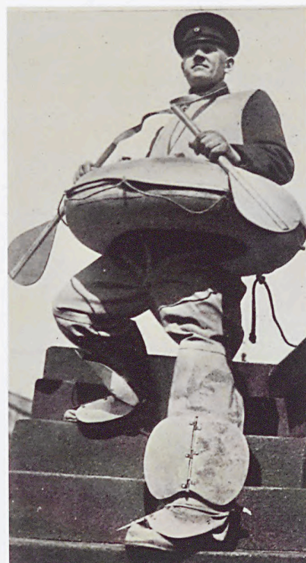
Luftgefüllter Schwimmrettungsanzug der Berliner Feuerwehr mit Rettungsring, Paddeln, Ruderflossen und Leine (Das neue Universum 1936, S. 21).
