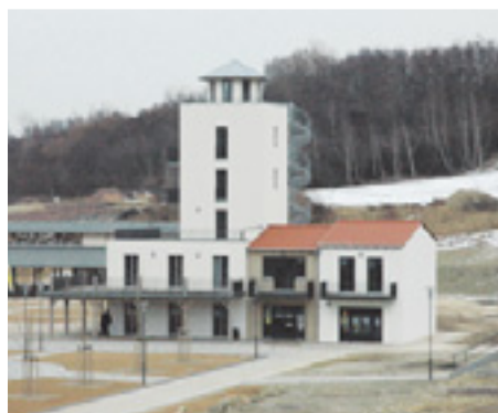
Hafenturm in Muecheln: Die DLRG hat dort bereits Räumlichkeiten bezogen
